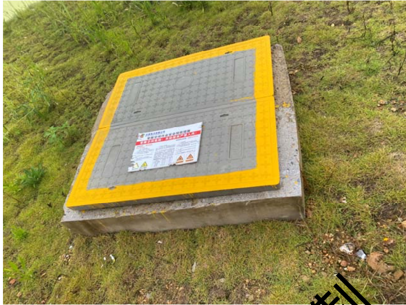
升压站内生活污水处理设施
